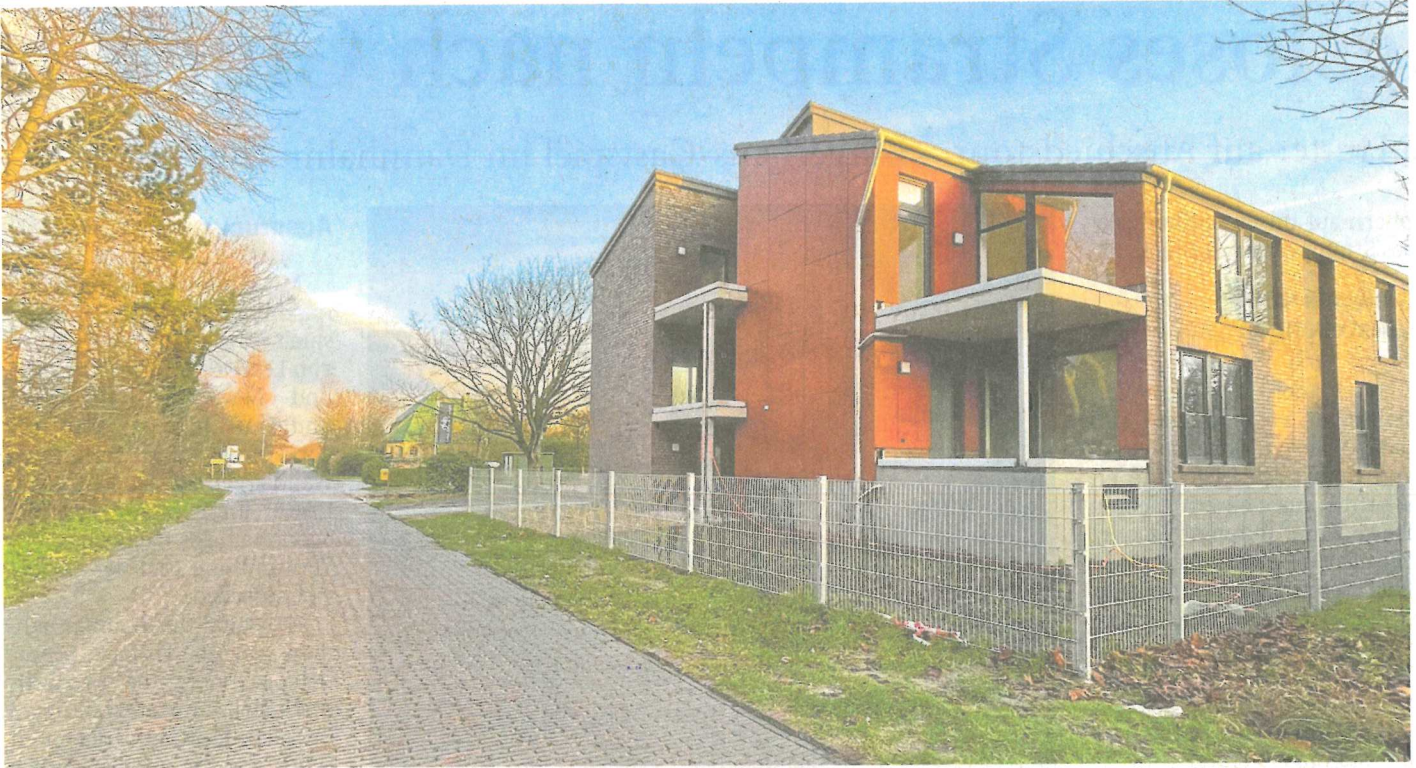
Auf Wangerooge entstand an der Siedlerstraße 2021 dieses Mehrfamilienhaus der Wohnungsbaugesellschaft Friesland. Ganz in der Nähe entsteht nun ein weiteres nahezu baugleiches Objekt.
